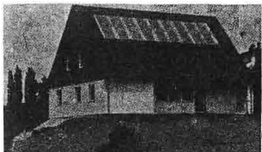
Sl. 70a. Filipsova eksperimentalna kuća u Ahenu sa čelijama za korišćenje Sunčeve energije
