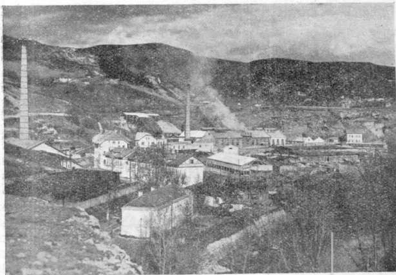
Sl. 43. Elektrohemijska fabrika u Jajcu. (Bosansko d. d. za elektrinu.)
