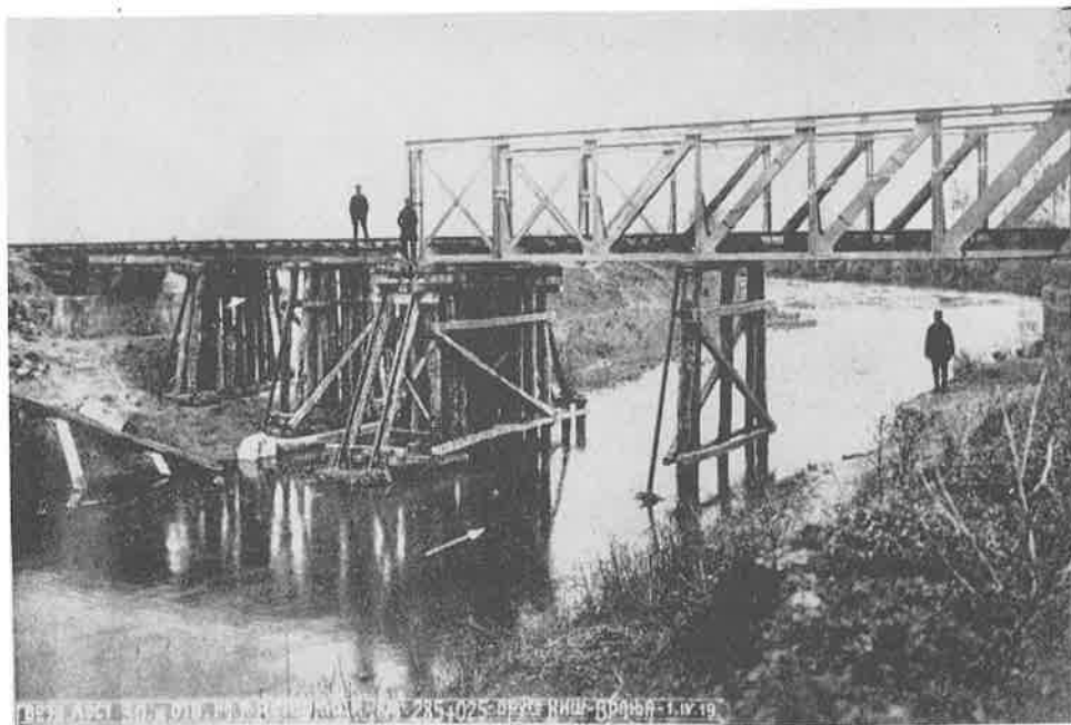
Об'їрка срушеної залїзничкої мостї на Вейжерницї (снимљено 1919. ї одине)
