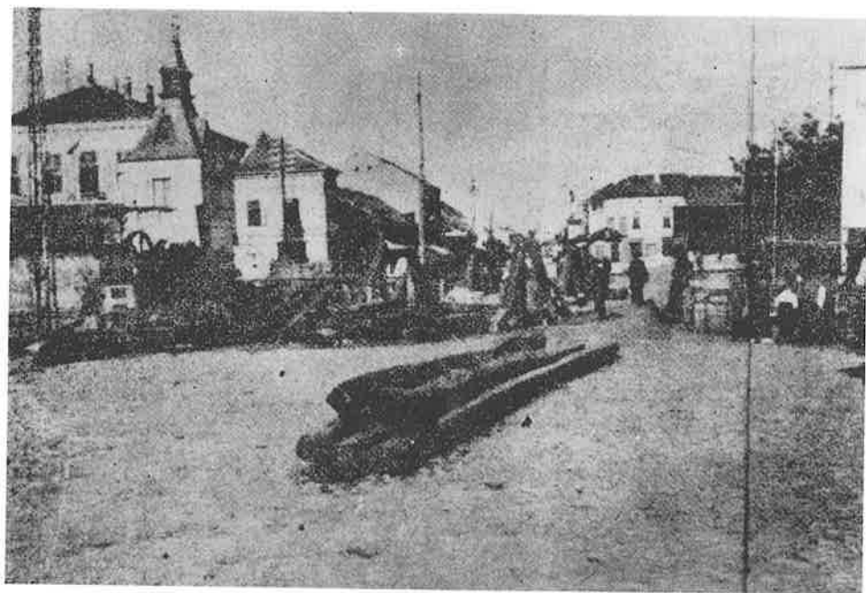
Подизање нове, уске моста на месту старе ћурије
