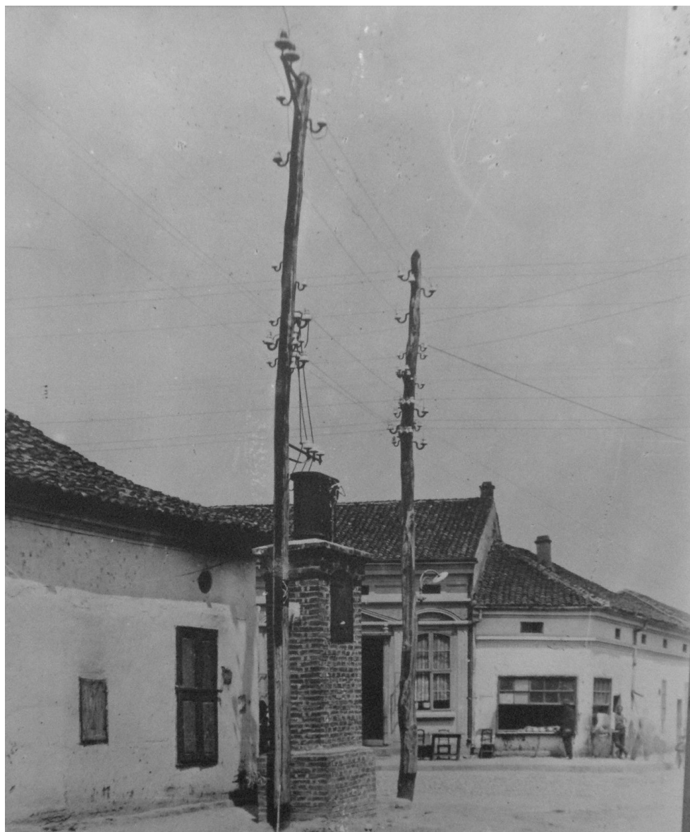
Слика 6: Изглед једне од трафо станица из времена када је Ђорђе Станојевић градио електричне централе по Србији. Фотографија из његове спомен собе у Неготину.
