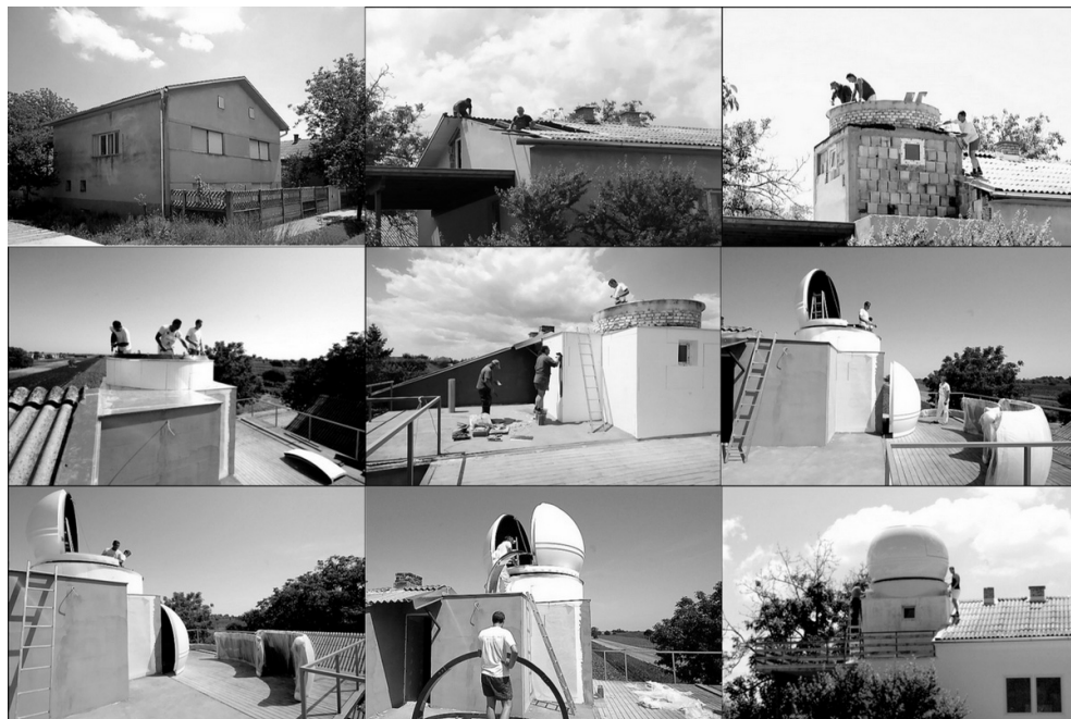
Слика 10: Изградња посматрачке куле и монтирање куполе 4 - 29. јун 2012.
